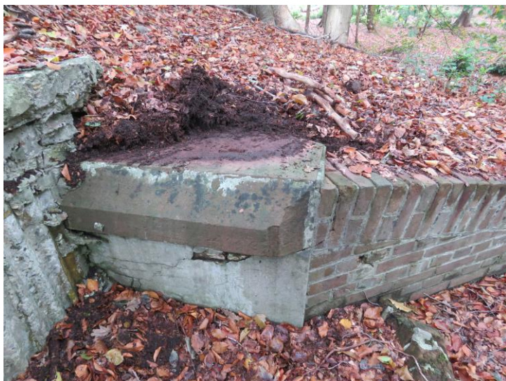
afb. 14 – waterslagen in rode zandsteen
